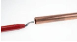
Ébavurer les bords intérieurs et extérieurs (tube métal) ; lorsqu'un cintrage du tube est nécessaire, le réaliser avant le raccordement.
