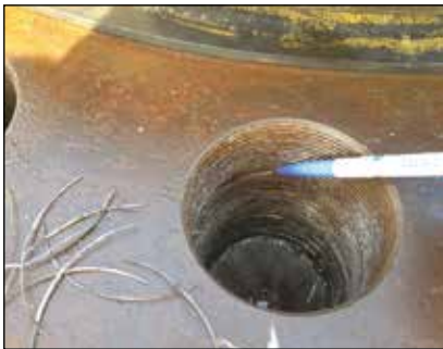
▲ Un filetage type une fois remis en état
