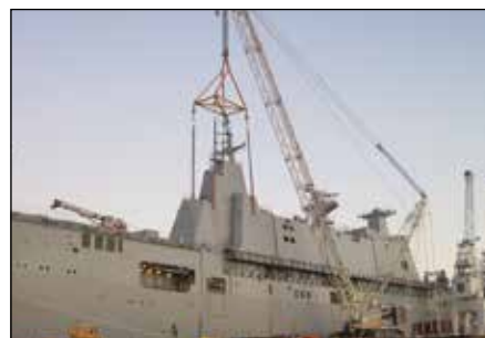
Levage et positionnement de charge synchronisés
