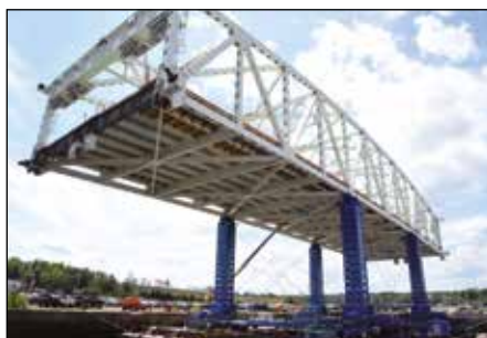
Levage progressif de pont
