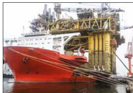
Super-levage et pose synchronisés
