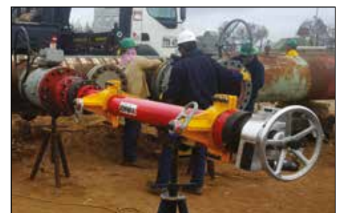
▲ Utilisation de la machine de piquage en charge CHT3000 sur des pipelines de l'industrie pétrochimique.
