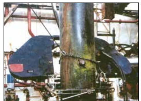
▼ Démantèlement à l'aide d'une scie à ruban.
